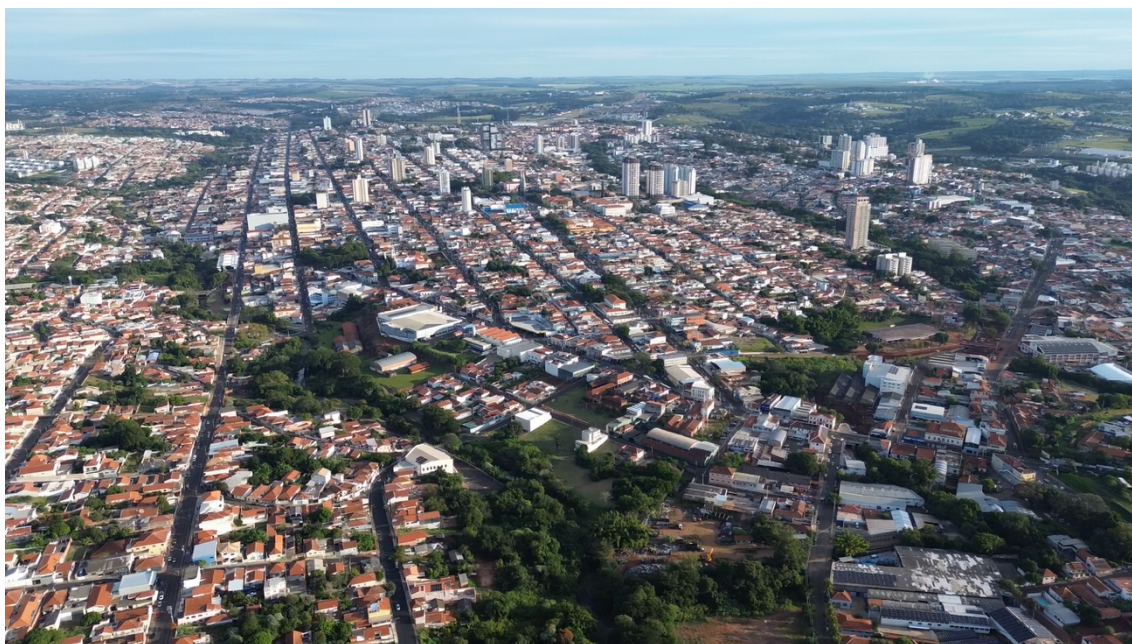
Figura 15 Vista do centro entre o Rio Lavapés (esq.) e o Córrego Tanquinho (dir.)
